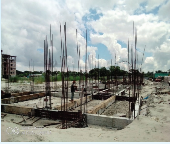
নির্মাণাধীন একাডেমিক ভবন
